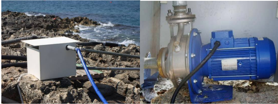
C8 Fig.6 – Sistemazione della seconda pompa di aspirazione non sommersa..
