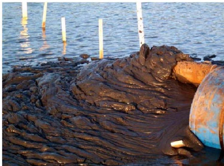
**Figura 44.** – Sedimenti rimossi con *dry-dredging*.
