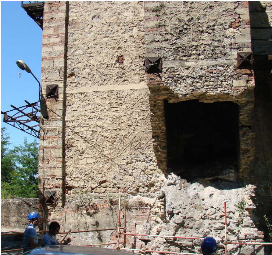
Foto 4 lato nord bag house non ancora conterminato
