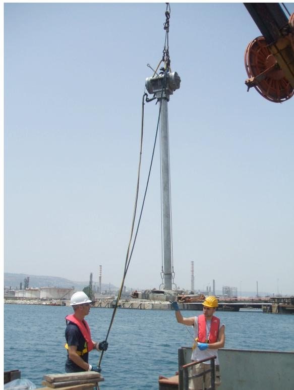
**Fig. 2c- Fase di preparazione per l'inizio di un'attività di perforazione tramite carotiere a vibrazione.**
